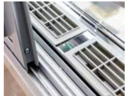
Laufschiene der Schiebetür und Luftführungsgitter
